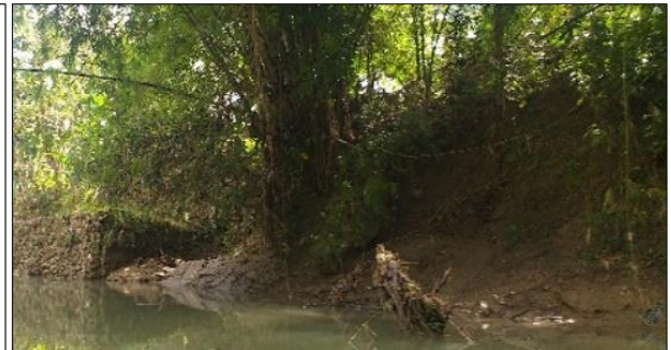
Gambar 15 Prediksi keruntuhan penampang K.11+00 pada 19/07/2021, namun pada dokumentasi 08/08/2022 tebing belum mengalami keruntuhan
