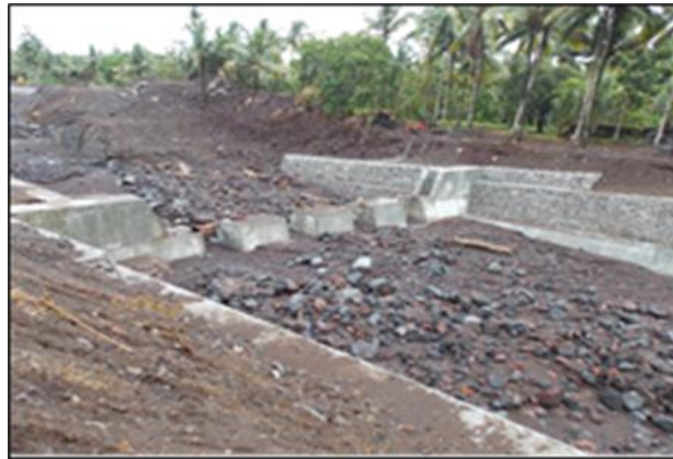
Gambar 4 Sabodam TG-D15 di sta. 2+200 tertimbun material lahar
