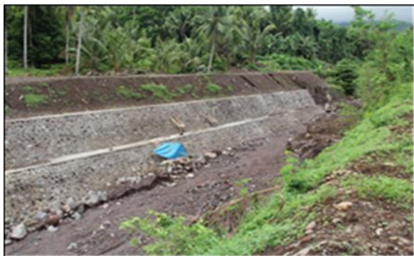
Gambar 3 Revetment pada alur sungai di sta. 1+650 ~ 1+750
