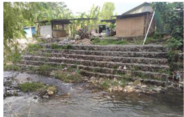
Gambar 10 Contoh pelindung tebing dengan bronjong yang dalam kondisi baik
