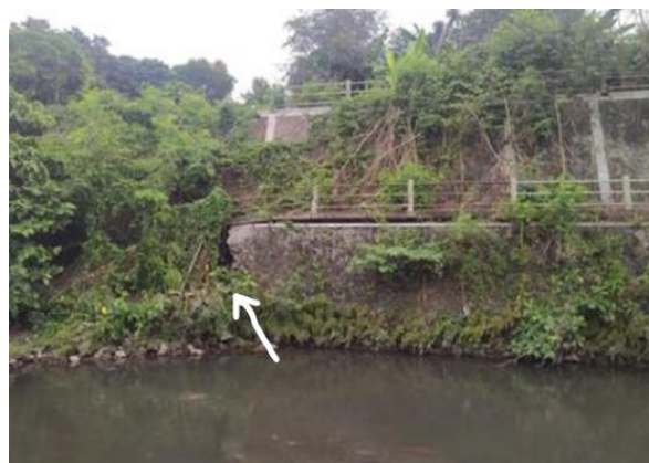
Gambar 9 Contoh DPT yang mengalami retak
