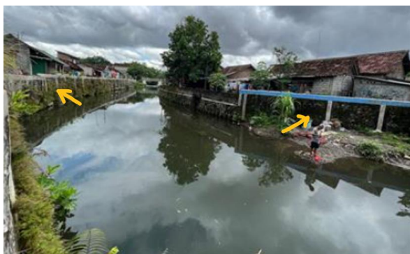
Gambar 1 Talud atau DPT yang melindungi rumah di kiri dan kanan sungai dari erosi tebing
