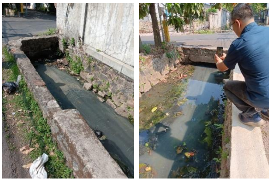
Gambar 11 Bottle neck pada node J10-J11 akibat sedimentasi (Wijaya et al., 2024)
