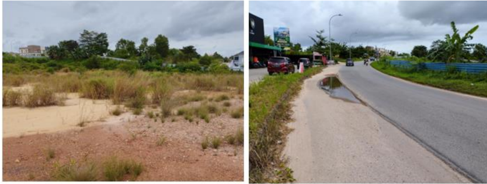
Gambar 11 Genangan di Jalan dan di Lokasi Pengukuran
